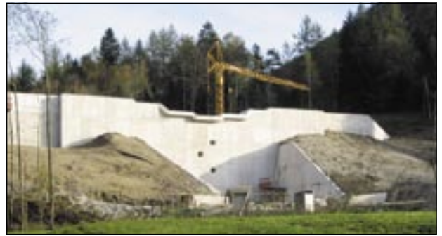
Hochwasserschutz Ansicht von Westen.
