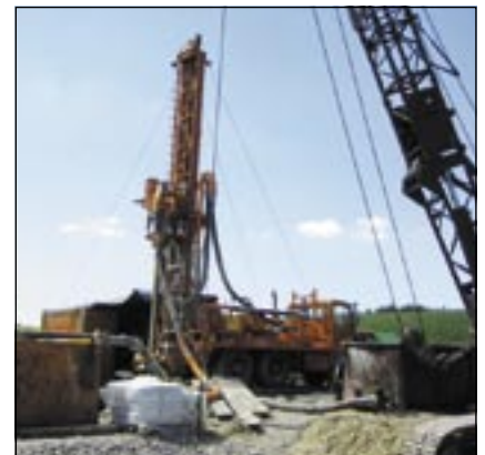
Herstellung des Brunnens 1 mit Bohrgerät der Fa. Eder Brunnenbau.
