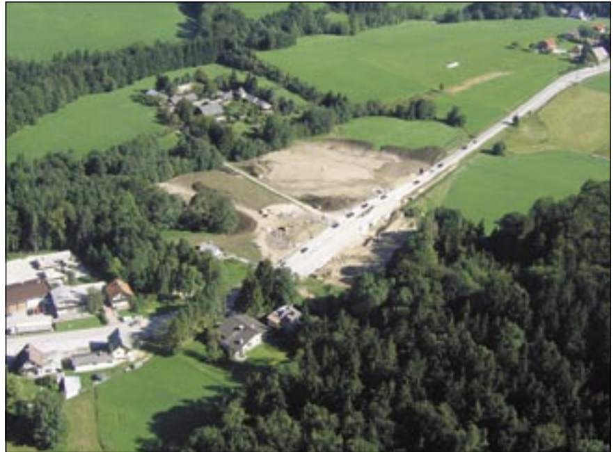
Baustelle B 158 Wolfgangseestraße Bereich Guggenthal.
