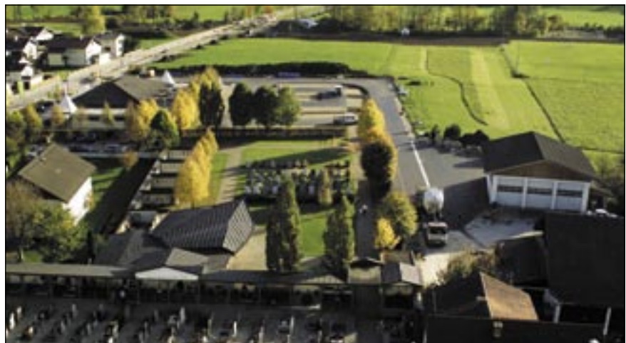
Umsetzung der Hochwasserschutzmaßnahmen Fuschler Ache im Bereich des Ortszentrums von Thalgau (Hochwasserdamm und Brückenhebung).
