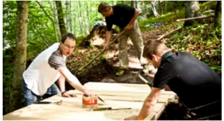
Die ehrenamtlichen Helfer setzen Wege instand und reparieren Sitzbänke.
